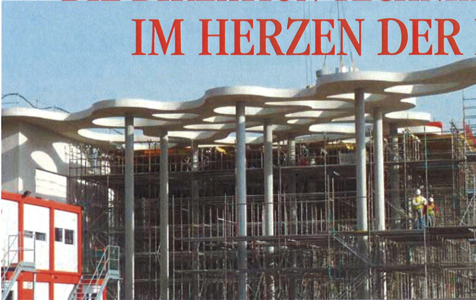
Die Pergola – ein 40 cm starkes „Betonblatt“ von 4'500 m 2 und mit einem Gewicht von 3'000 Tonnen – liegt auf 96 Pfosten von 9 bis 18 Metern Höhe auf.
