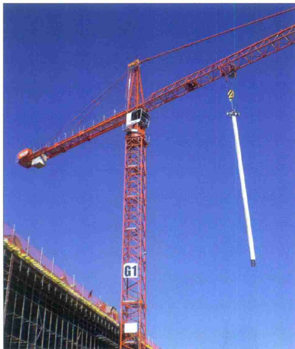
Levage des piliers.
