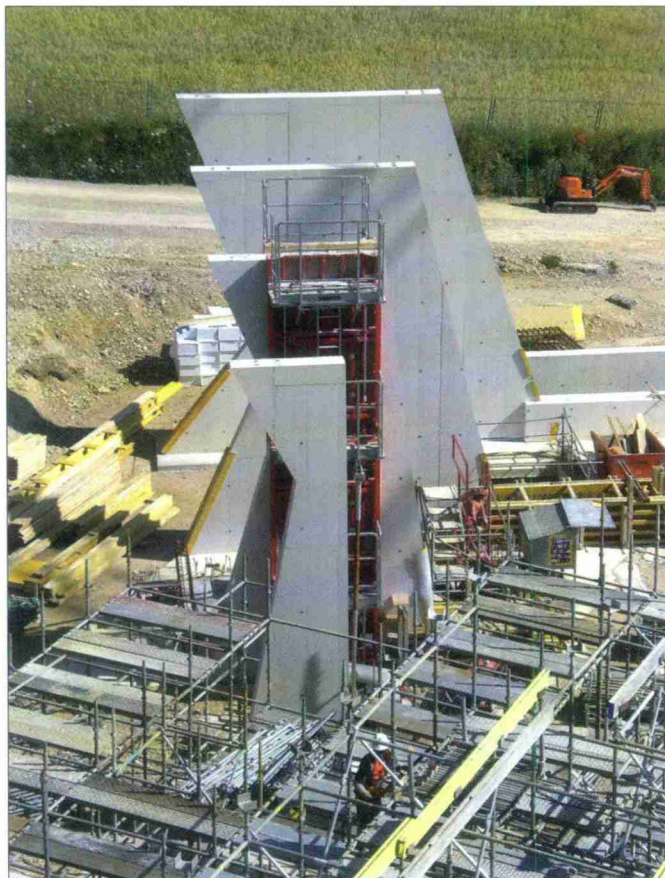
Insertion des piliers.
